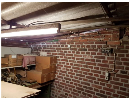
Foto 5: P 3 Wellasbestplatte 23.11.2020
